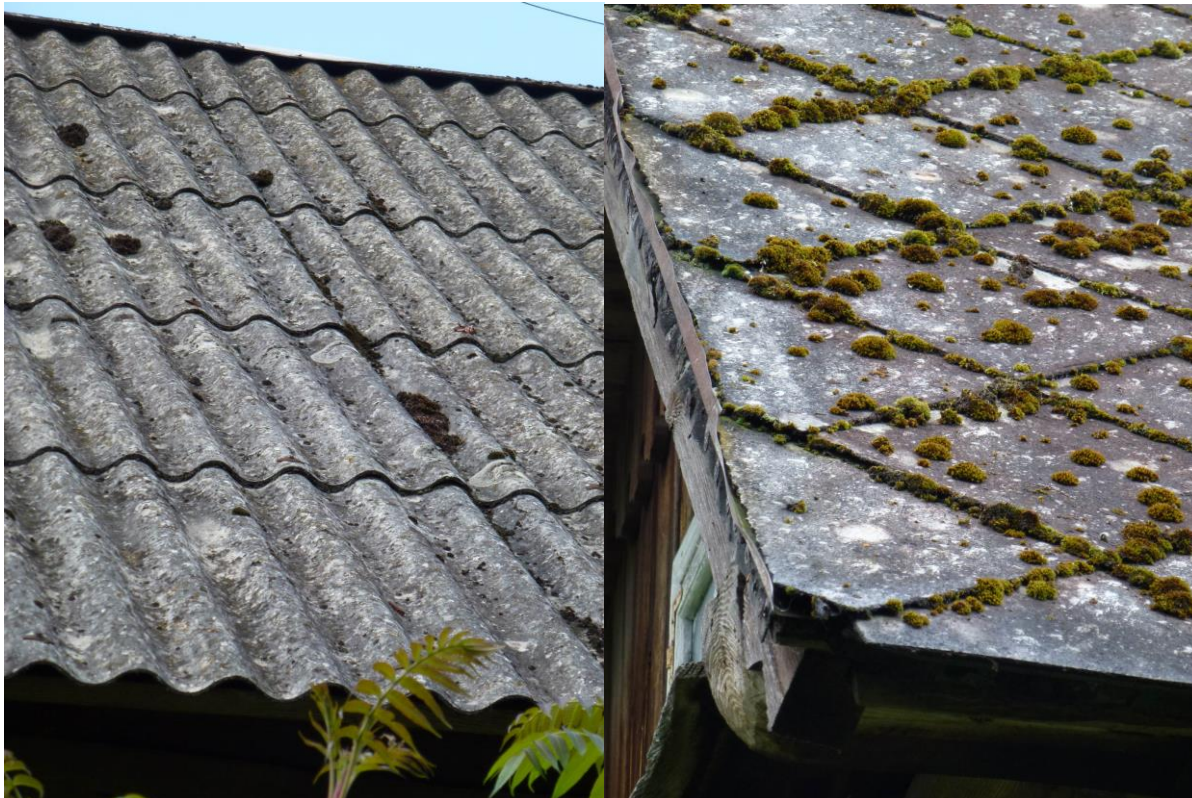
Rysunek 1. Najpopularniejsze w Polsce wyroby azbestowo – cementowe: płyty faliste oraz romboidalne (Źródło: Fotografie własne)
