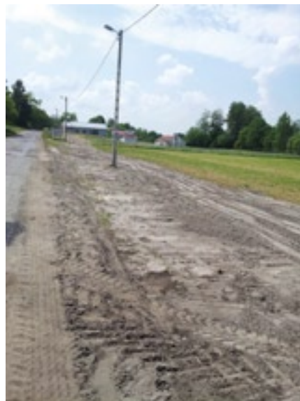
Budowa sieci wodociągowej w Kępie Niemojevskiej
